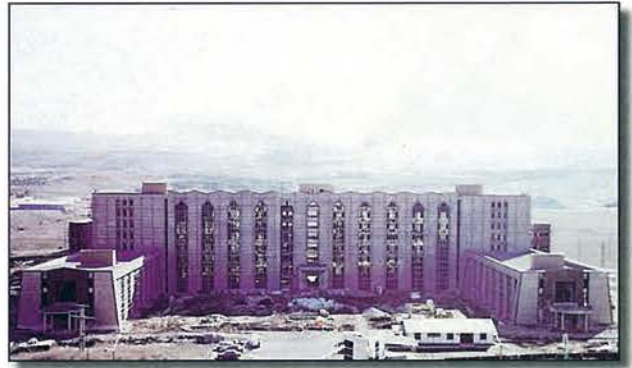
Diyanet İşleri Başkanlığı Hizmet Binası İnşaatı
