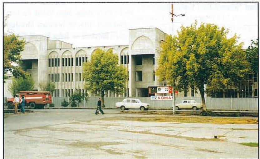
Aşkabat'ta Vakfımızca inşa ettirilmekte olan İlahiyat Fakültesi binası.
