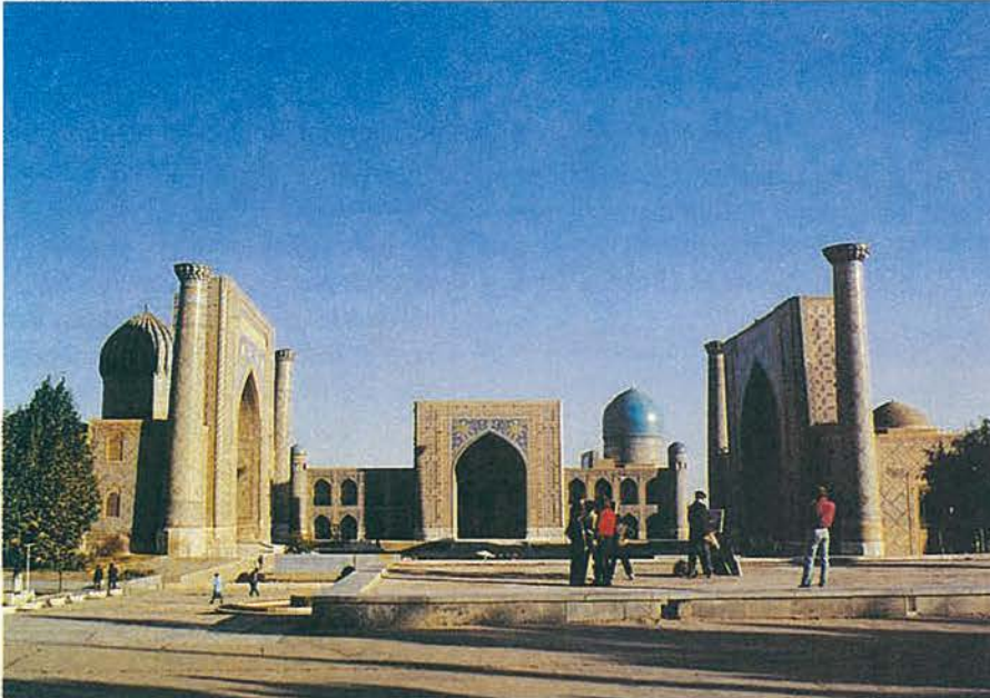
Semerkand. Registan meydanı. Solda Uluğ Bey Medresesi, ortada Tileykârî Medresesi, sağda Şîr-Dâr Medresesi.
