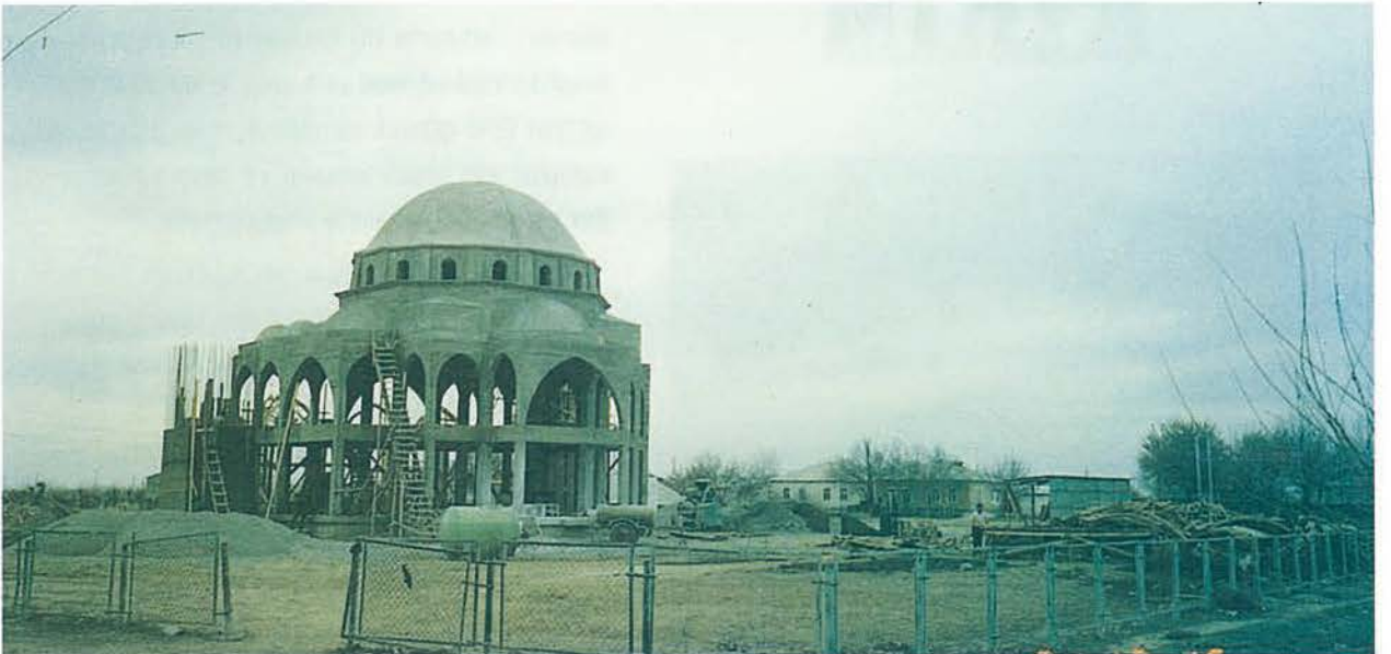
Vakfımız tarafından yaptırılan Aşkabat Kıpçak Camii inşaatı.
