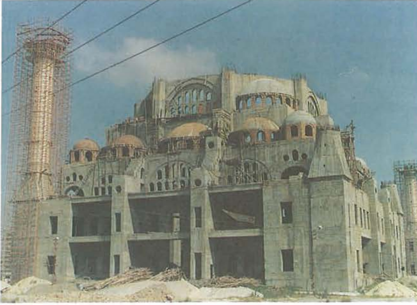
Çalışmalarıyla takdir toplayan rahmetli Süleyman Tekin'in Adana'da başlattığı Adana Merkez Camii inşaatı.
