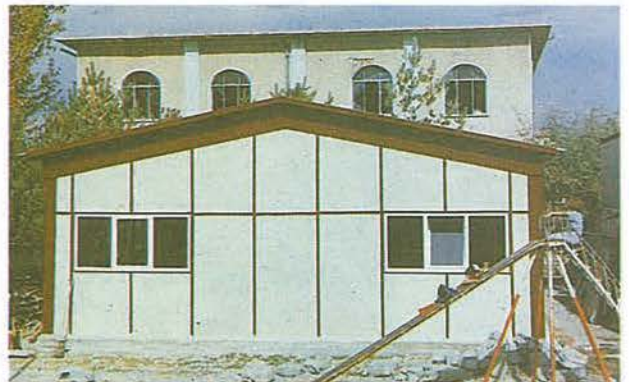
Depremde ağır hasar gören Halit Paşa Camii önünde yapılan prefabrik mescid
