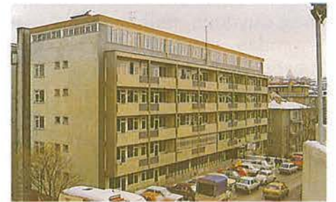
Diyanet İşleri Başkanlığı Merkez Binası
