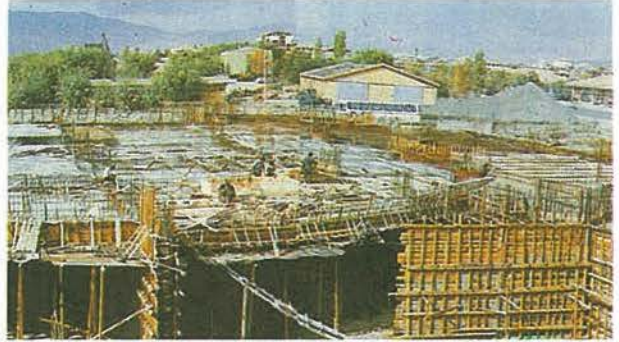
Büyük bir külliye şeklinde yapılan Terzibaba Camii
