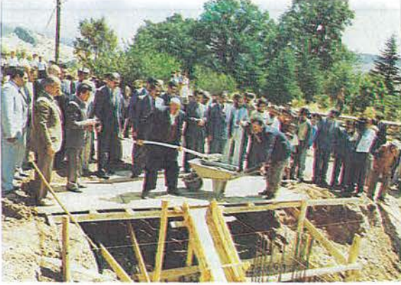
▲ Aksu Müftülük Sitesi
