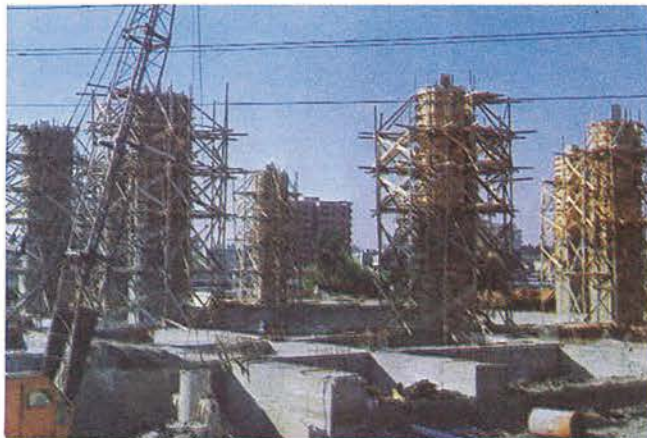
Adana Merkez Camii inşaatı
