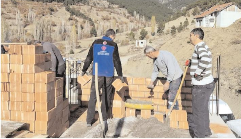
Çukuröz Köyü'nde yangında evlerini kaybeden vatandaşlara Müftülük ve Türkiye Diyanet Vakfı (TDV) yardım eli uzattı.
