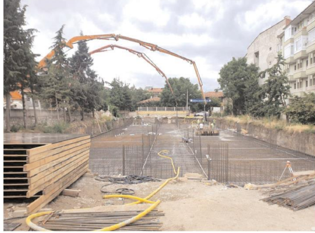
Kuran kursu binası Akşemseddin Camii arkasında yapılıyor.
