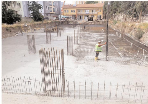
İnşaatın 15 gün içerisinde su basmanı ve perde beton işlemleri tamamlanacak.
