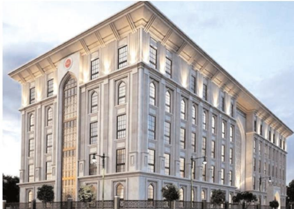
Yıkılan Hıdırlık Kur'an Kursunun yerine modern bir bina yapılacak.
