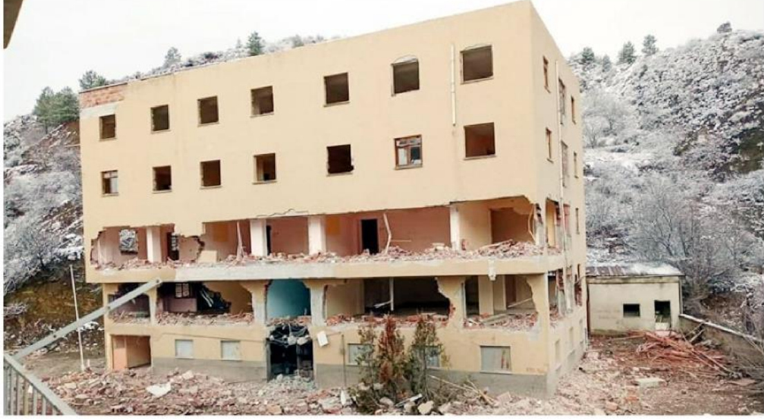
Bina yıkıldıktan sonra yerine Kız Kur'an Kursu yapılacaktır.
