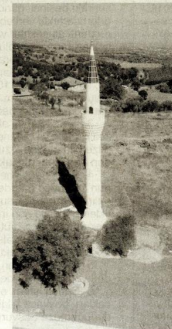
1969 yılında meydana gelen depreme yıkılan caminin minaresi
