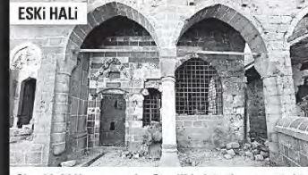
ESKİ HALİ Cizre'deki Hayrseverler Camii' de büyük zarar gördü.
