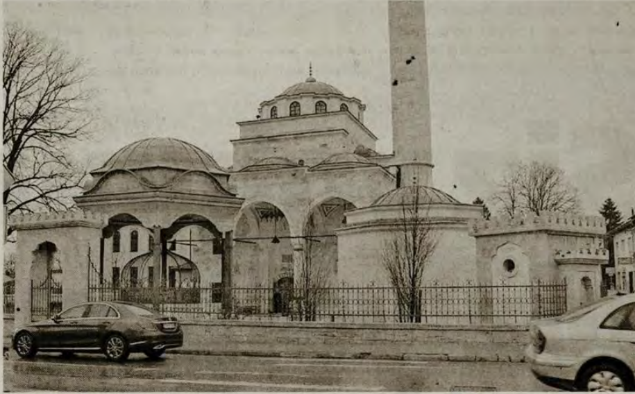
Ferhadiye Camisi, 7 Mayıs 1993 tarihinde Sırpların temellerine dinamit yerleştirmesi sonucu yıkılmıştı. Cami TİKA'nın desteği ile yeniden yapıldı.
