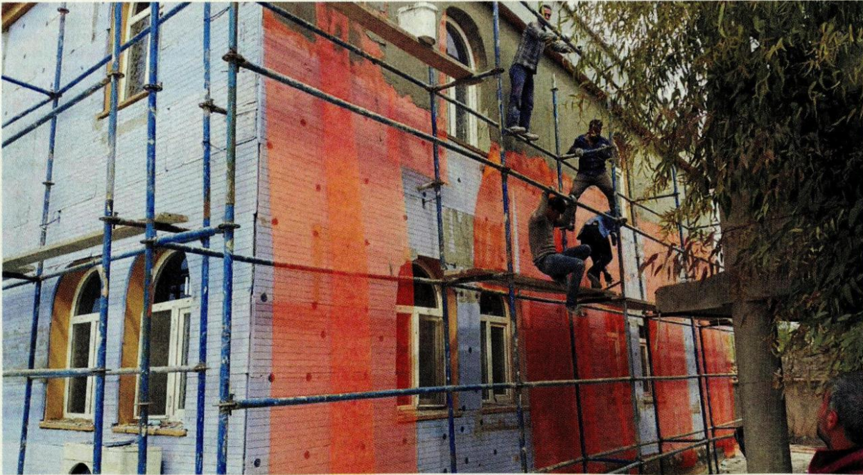
Terör örgütü PKK mensuplarının saldırılarında tahrip olan Cizre ve Silopi'deki 57 caminin tamir ve tadilatı yapılıyor.
